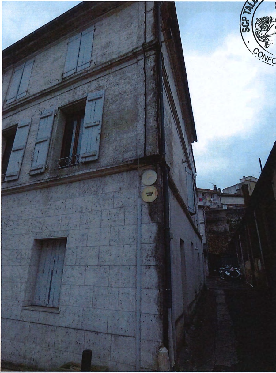
Façade avant immeuble 160 et mur pignon avec passage vers cour.
