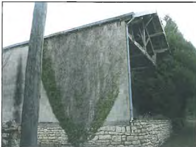
Pignon Est et façade Sud
