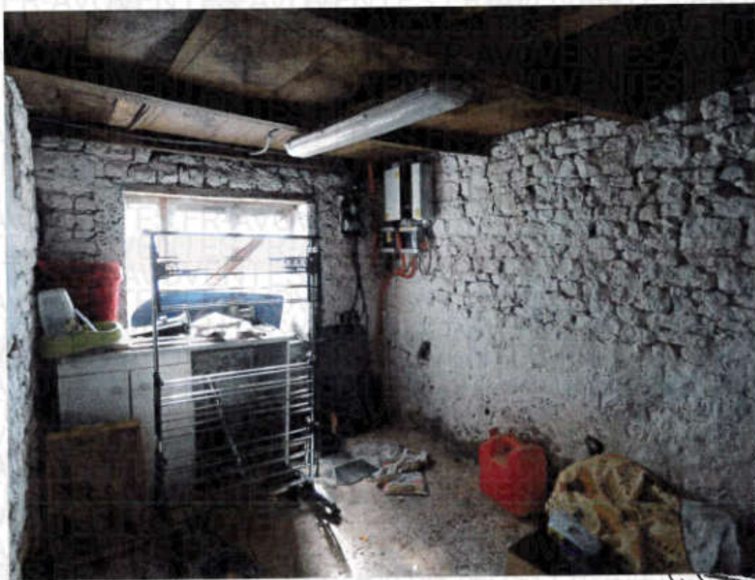
Côté gauche, existence d'une pièce comportant un sol en béton, des murs en pierres et un plafond en poutres apparentes et plancher sur le dessus.
