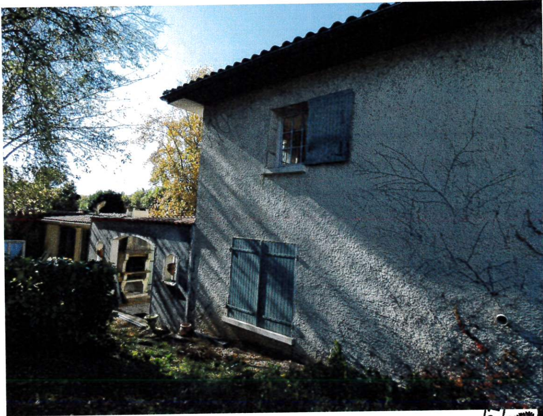
Façade exposée SUD-EST
